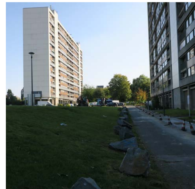
Hoge toren van de blokken 1 en 2 : Essegem site bron: fotografie Arter ©
