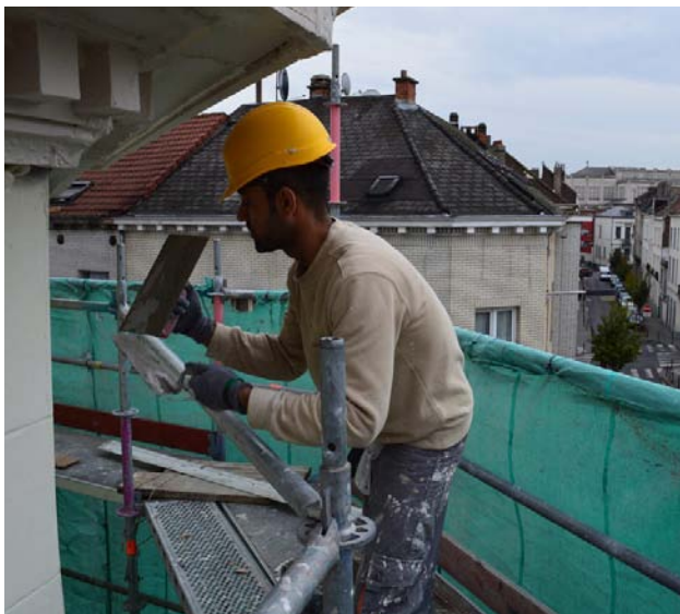
| "Renovatie en isolering van de gevels" - Casablanca, Brussel bron: Casablanca ©
